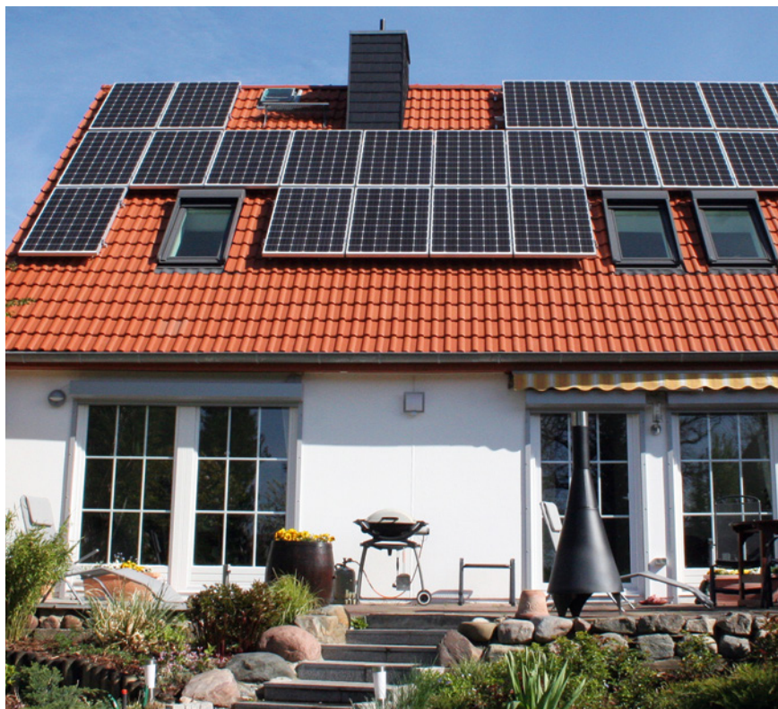
Familie Reuter hat ihr Einfamilienhaus in Berlin-Spandau energetisch modernisiert. Im Heizungskeller erwärmt ein Buderus Öl-Brennwertkessel Logano plus GB145 das Heiz- und Trinkwasser, der zur Hälfte mit einem neuartigen Heizöl läuft.
